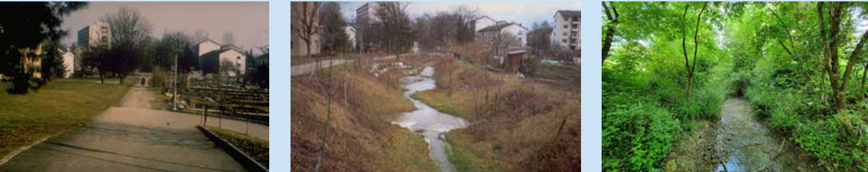
Fig. 37: La remise à ciel ouvert de l'Hirzenbach à Schwamendingen a duré de 1987 à 1992 et a complètement transformé le paysage urbain. Là où s'étendait autrefois une chaussée (à gauche) coule maintenant l'Hirzenbach libéré de son carcan. Tout d'abord bordé d'une végétation éparse (au milieu), il est aujourd'hui entouré d'un peuplement dense d'arbres et de buissons (à droite). Photos de gauche et du milieu AWEL Zürich ; photo de droite Hektor Schnorf
