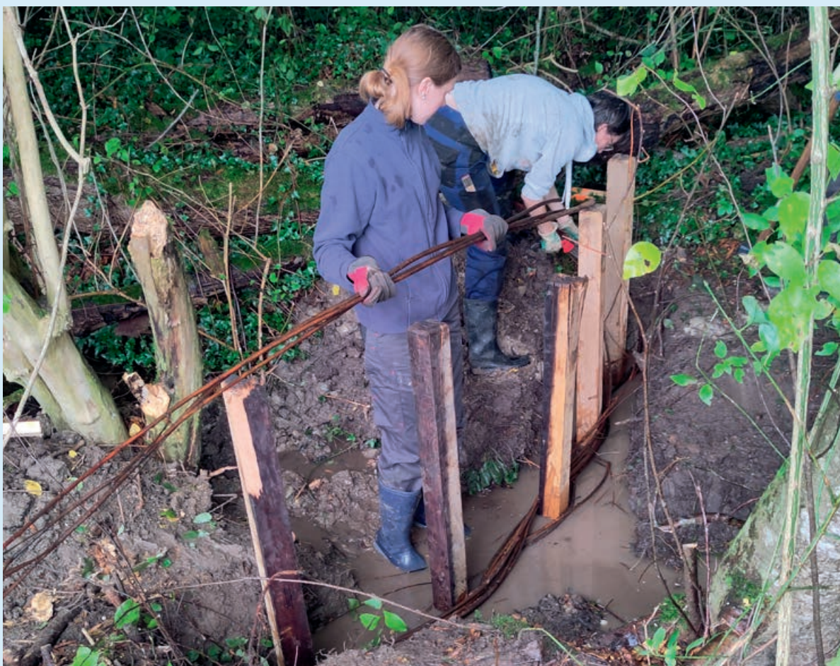
Figure 22 Construction d'un BDA par des pieux plantés, complétés par un treillis de saule. Photo : Niels Werdenberg, Emch+Berger AG Berne
