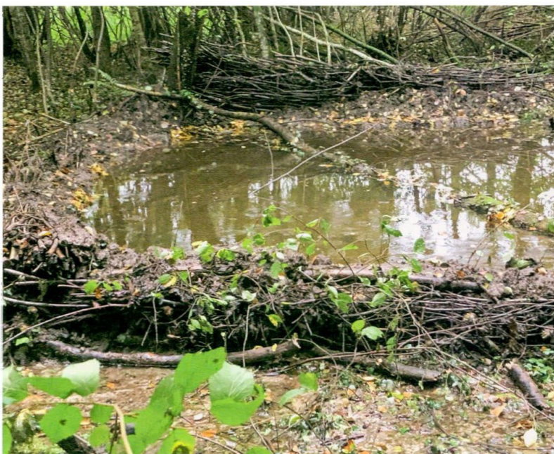
Ganz links, oben und Mitte: Impressionen vom Bau künstlicher Biber-Dämme im Höllwald bei Münchenbuchsee. Ganz unten: Die Flechtdämme schaffen Aufstau-Bereiche und Bachverzweigungen. © Nicolas Stettler (3); Thomas Scheurer
