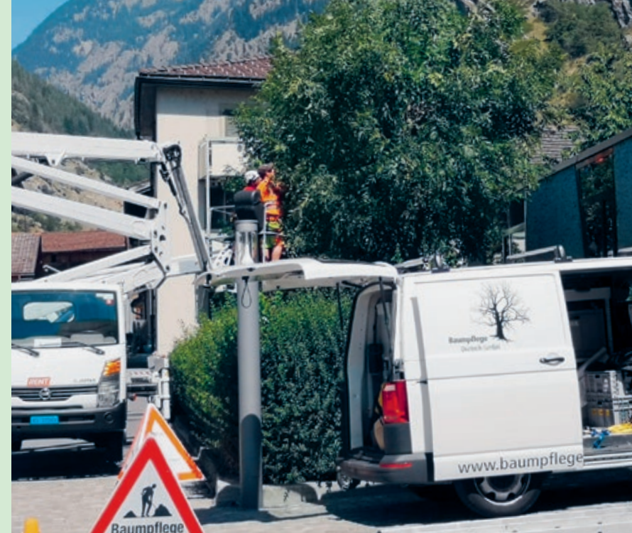
La signalisation et l'usage d'une nacelle élévatrice constituent des mesures indispensables pour assurer la sécurité lors de l'entretien des arbres.
