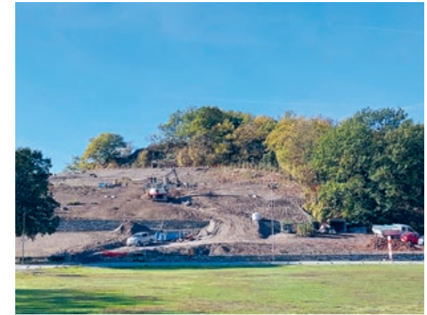
Novembre 2022, poursuite des travaux grâce à de bonnes conditions météorologiques.
