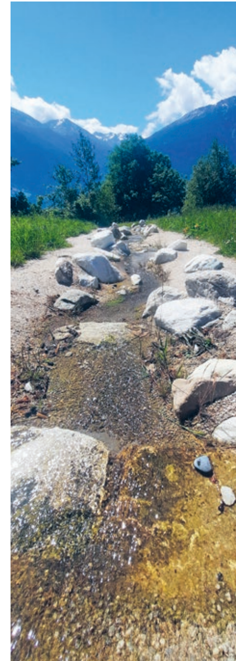
Aménagement naturel du cours d'eau Lätzi Tolu.
